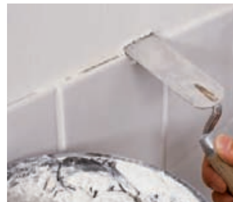
13 Kanten ohne Kunststoffprofil, die später durch Möblierung verdeckt sind, werden mit steif angesetzter Fugenmasse geschlossen.
