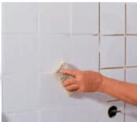
12 Mit einem feuchten Schwamm, der häufig ausgespült wird, wischt man überschüssige Fugenmasse ab. Es bleibt ein leichter Schleier.
