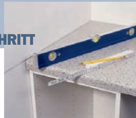
1 Zunächst werden Unterkante und Höhe des künftigen Fliesenschilds auf die Wand gezeichnet, so dass er später auf den Möbeln endet.
