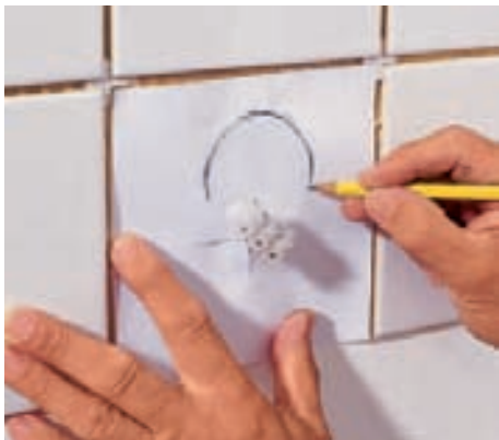
9 Wo Steckdosen oder Wasseranschlüsse hinkommen, fehlen die Fliesen noch und die Ausschnitte werden auf eine Schablone übertragen.
