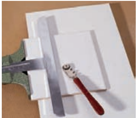
6 Streifen für Innenecken und Sockel werden mit dem Fliesenbehuapparat abgemessen und die Glasurseite mit dem Glasschneider angeritzt.
