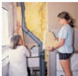
Die Vorwandinstallation machen am besten echte Könner. Aber die folgende Isolierung ist wirklich leicht.
