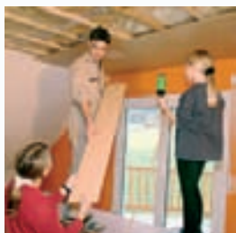
Deckenmontage im Dach gelingt im Familienteam locker. Sechs Hände halten eben mehr als zwei.
