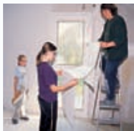
Tapezieren ist nicht schwer – wenn man gerade Wände hat und die neue Vlies-Technik nützt.
