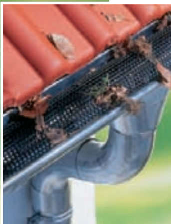
Ein Laubfanggitter aus Kunststoff (Marley, 2 m etwa 10 Euro) lässt sich leicht in jede halbrunde Rinne legen. Laub bleibt obenauf liegen, unten fließt das Wasser ab.
