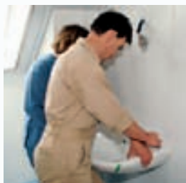
Die Montage der Sanitär-elemente ist dank der perfekten Vorarbeit für die Volks eine leichte Aufgabe.
