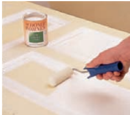
10 Dann sind die Füllungen in der Mitte dran. Da jetzt größere Flächen gestrichen werden, kann eine Schaumstoffrolle eingesetzt werden.
