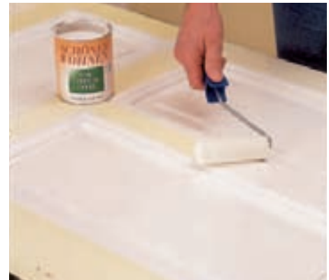
11 Zum Schluss werden die Rahmen um die Füllungen herum vorgestrichen. Den Vorlack zügig und gleichmäßig mit der Rolle verteilen.
