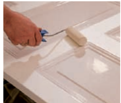
16 Dieses Arbeit ist die gleiche wie beim Vorstrich, auch hier wird zum Schluss die Umrahmung der Füllungen lackiert.
