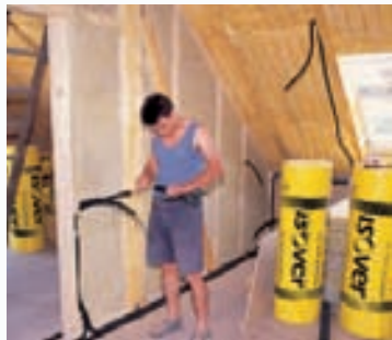
Elektroinstallation ist ganz einfach, wenn Planung und Vorarbeit stimmen.
