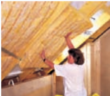
Dämmung ist bei einem Neubau nicht schwer. Gisela Volk kommt gut voran.
