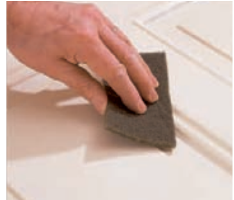
8 Ist der alte Lack hart und fest, braucht er nur mit einem feinen Schleifpad angeschliffen zu werden. Wichtig: Gründlich entstauben!
