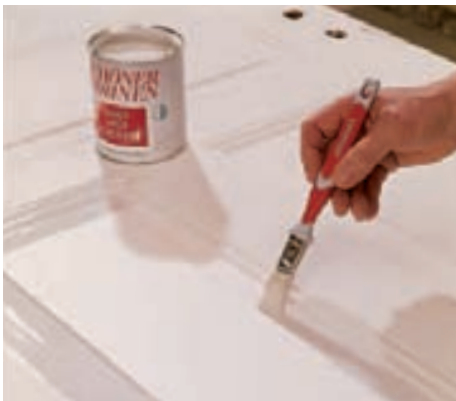
14 Beim Lackieren geht man genauso vor wie beim Vorstrich. Immer von innen nach außen. Erst mit einem Pinsel die tiefen Stellen und ...
