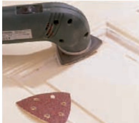
7 Die getrockneten Spachtelstellen schleift man mit einem groben Schleifpapier (80er) vor, danach noch einmal mit einem feinen (120er).
