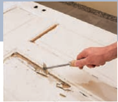
4 Mit dem Dreikantschaber können die losen und hochgekommenen Lackstellen und Blasen an den Profilen der Tür herausgekratzt werden.
