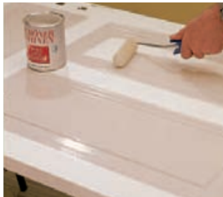
15 ... dann die Füllungen. Während beim Vorstrich eine Schaumrolle benutzt wurde, kommt jetzt eine beflockte Schaumrolle zum Einsatz.
