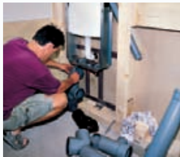
Sanitärinstallation: Vor der Vorwandinstallation steht das Teile-Puzzle...
