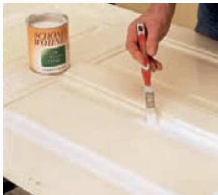
9 Für ein gutes Lackierbild muss bereits beim Vorstrich eine bestimmte Reihenfolge eingehalten werden: Zuerst die tiefen Teile streichen.
