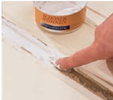
5 Da der feste Altanstrich erhalten bleibt, muss mit einer Spachtelmasse der entstandene Riss an der Füllung ausgeglichen werden.
