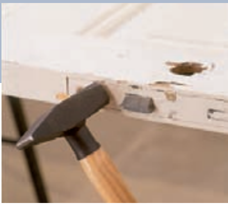
2 Das Türschloss ist oft mit Farbe verklebt. Ein paar leichte Schläge mit dem Hammer lösen den Altanstrich und lockern die Schrauben.
