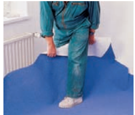
2 Den abgerollten Teppich aus einer rechtwinkligen Ecke beginnend auslegen. Für Nischen und Türen Materialzugaben vorsehen.
