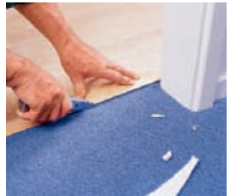
10 Bei Übergängen wird eine Metallschiene eingesetzt. Sie lässt sich auch prima als Schneidleiste für den überstehenden Teppich nutzen.
