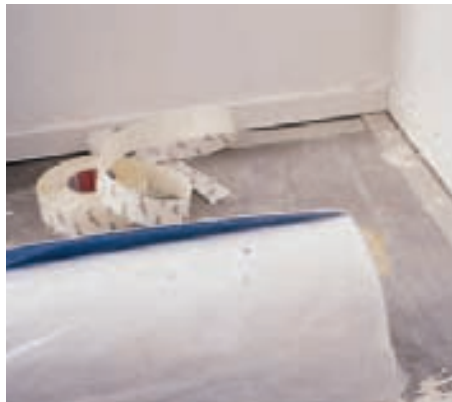
1 Wenn der Fußboden staubfrei ist und die Unebenheiten ausgeglichen sind, wird eine Bahn Teppichklebeband ringsum im Zimmer verklebt.
