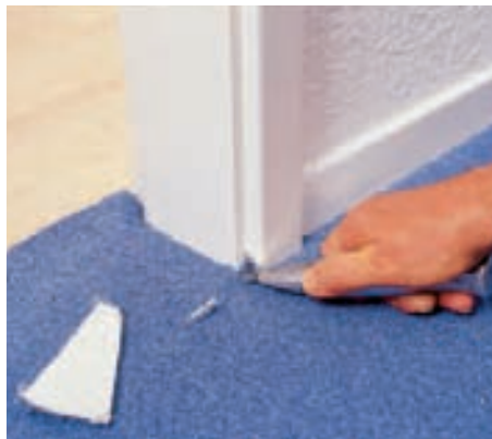
9 Das grob vorgeschchnittene Teppichstück in der Türöffnung wird präzise eingepasst, die feinen Ecken mit dem Teppichmesser geschnitten.
