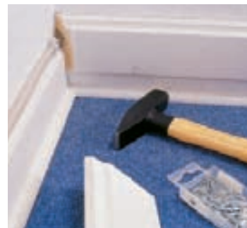
Die fertig gestrichenen Leisten mit dünnen Nägeln auf die vorhandene Sockelleiste nageln.
