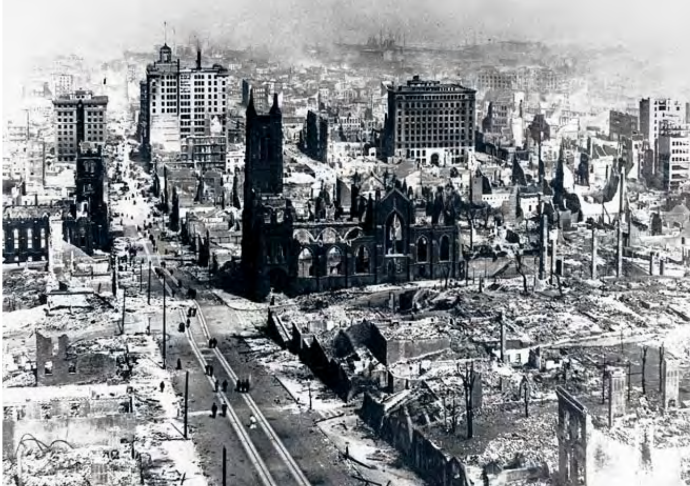
San Francisco nach dem Erdbeben von 1906: Großbrände durch geborstene Gasleitungen
