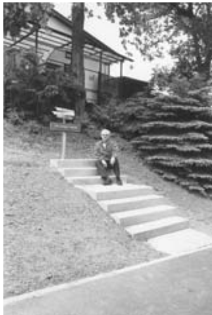
Die unnötige Treppe in Fritzlar
