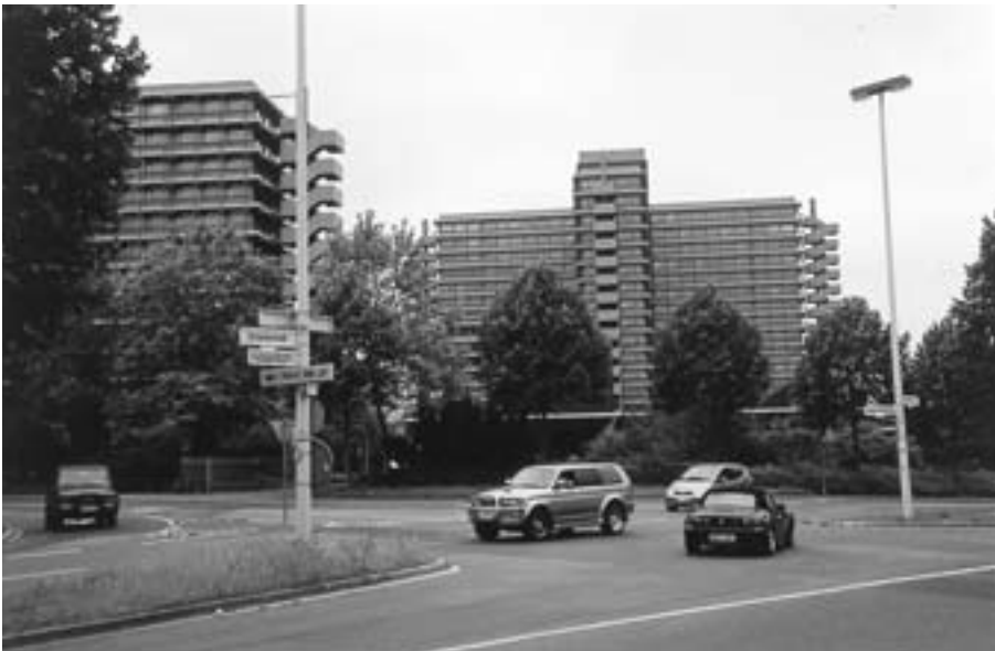
Bei der Sanierung der Kreuzbauten laufen die Kosten davon
