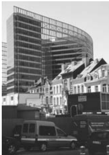
Palais Berlaymont – Sanierungskosten steigen und steigen
