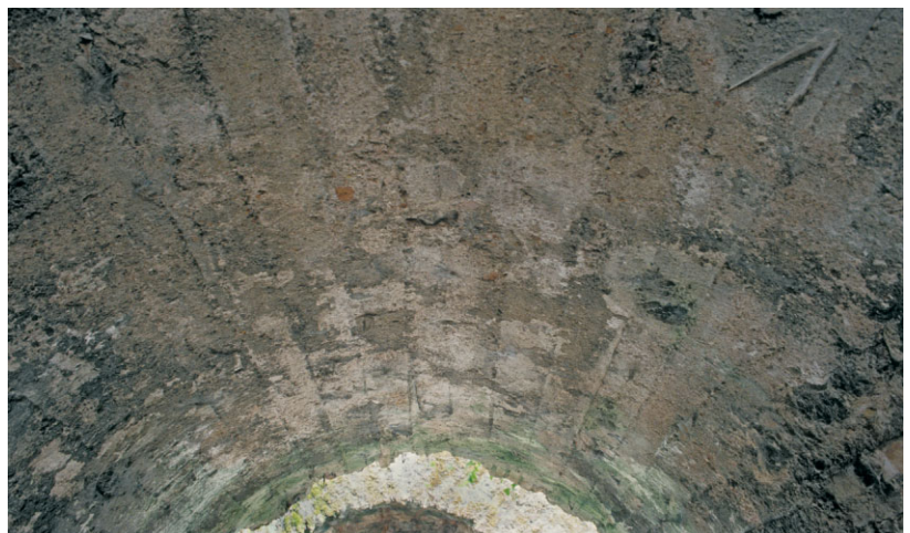
Abb. 1 Die Gewölbedecke dieses Ganges der Trierer Kaiserthermen ist mit römischem Opus Cementitium ausgeführt (Foto: Th. Zühmer, Rheinisches Landesmuseum Trier).
