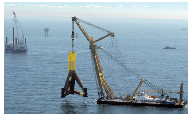
Abb. 1 Ein Schwimmkran positioniert einen Tripod für ein Windrad. Im Hintergrund links die Hubplattform Odin, rechts dahinter das Spannwerk (Foto: alpha ventus).
