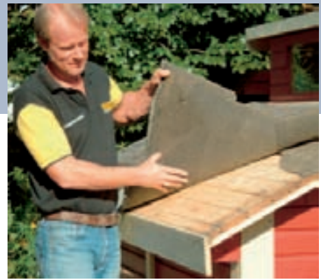
4 Die alte, defekte Deckung wird restlos vom Dach entfernt. Wo es geht, sollten auch die alten Nägel herausgezogen werden.
