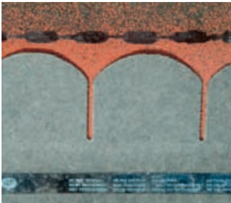
12 Durch Sonnenwärme und Eigengewicht verkleben die Reihen an den werksseitig angebrachten „Klebestreifen“ mit dem Untergrund.
