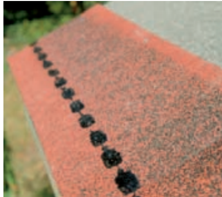
8 Die Anfangsreihe wird parallel zur Traufkante aufgenagelt, so dass sie mit der Unterdeckung mindestens bündig abschließt.
