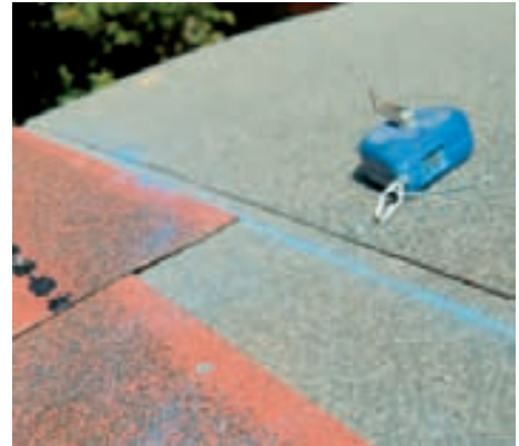
9 Zur Orientierung beim Verlegen der Schindeln wird etwa alle drei bis vier waagerechte Reihen eine Kreidelinie gezogen.
