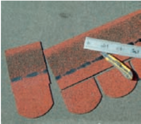
7 Die erste, unterste Reihe wird um eine Schindel gekürzt und alle Zungen abgeschnitten. So entstehen beim Decken keine Kreuzfugen.
