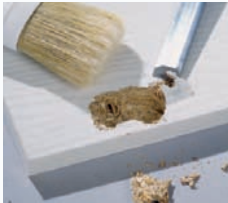
1 Türseite: Lose und eingerissene Teile werden mit dem Stechisen herausgearbeitet, Holzspäne und Schmutz mit dem Pinsel entfernt.
