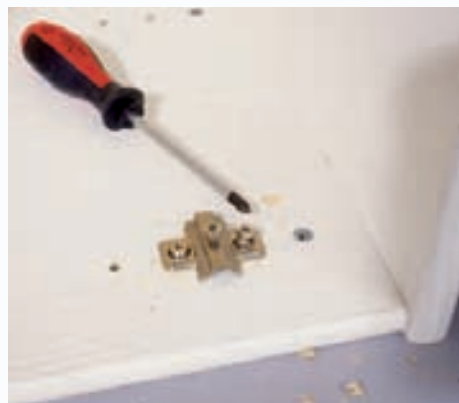
C Die Montageplatte, der Scharniersockel im Schrankkorpus, wird dann in der alten Position wieder festgeschraubt.
