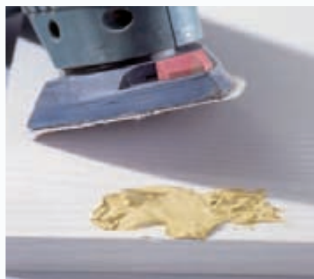
3 Wenn die Spachtelmasse ausgehärtet ist, werden die Überstände mit einem Stechisen abgestoßen und dann sauber verschliffen.
