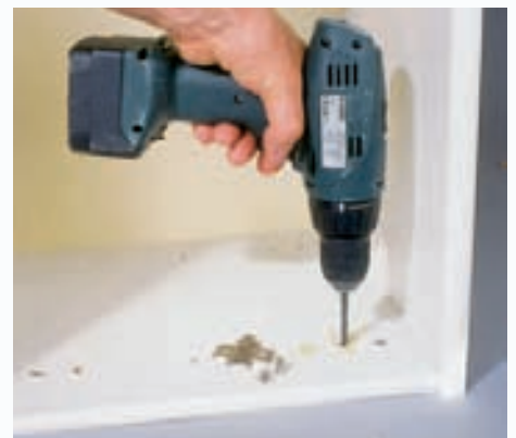
B Nach dem Durchtrocknen wird die harte Paste flächig verschliffen. Mit einem 5-mm-Bohrer werden neue Befestigungslöcher gebohrt.
