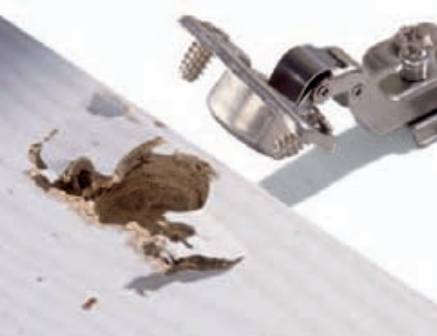
A Korpusseite: Sind die Schraublöcher von Montageplatten ausgebrochen, werden auch sie mit Zweikomponenten-Holzpaste verfüllt.
