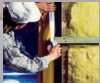
Mittels robuster Klebebänder , die auch dem Wetter trotzen, sind empfindliche Bauteile schnell geschützt.
