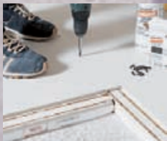
Feste Verbindungen von Trockenestrichelementen schaffen nicht die Schrauben, sondern der Kleber.
