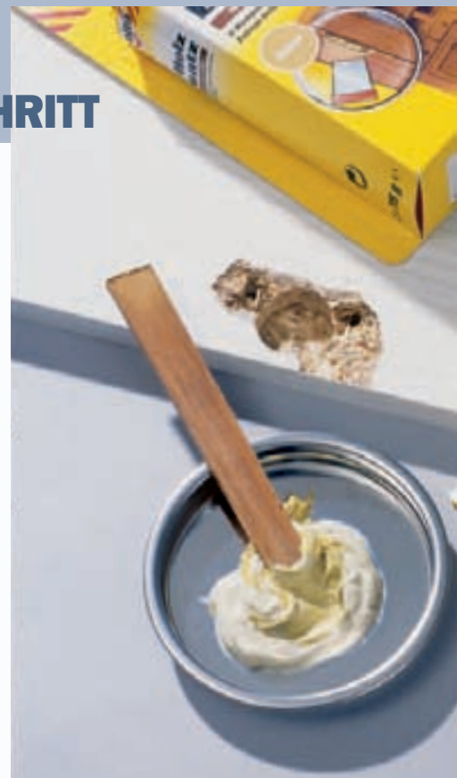
2 Mit Zweikomponenten-Holzpaste werden das ausgebrochene Scharnierloch sowie die Schraublöcher verfüllt.
