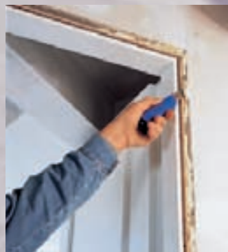
Expressmontage von Türen und Fenstern mit geeignetem Bauschaum ist Stand der Technik.
