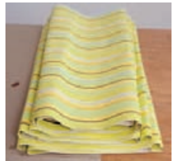
8 Arbeiten Sie drei bis vier Bahnen im Voraus, legen diese übereinander und lassen sie jetzt weichen. Die Tapete wird dadurch geschmeidig.
