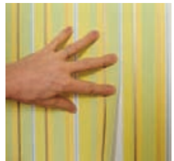
14 Auf Stoß kleben, so heißt es, wenn die nächste Tapetenbahn genau an der Kante der vorherigen ausgerichtet und geklebt wird.
