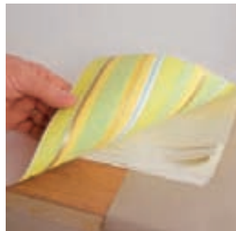
4 Schieben Sie alle Bahnen gefächert an den oberen Rand des Tapeziertisches und ziehen die erste Bahn bis an die Vorderkante.
