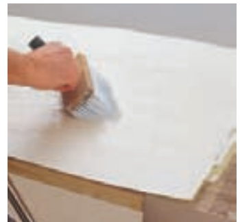
5 Jetzt kleistern Sie die nach vorn gelegte obere Bahn gleichmäßig, nicht zu dick, immer von der Bahnmitte zu den Kanten ein.
