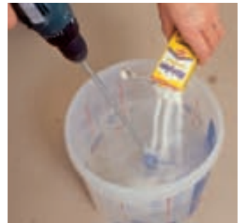
1 Zuerst wird der Kleister angerührt. Bringen Sie das Wasser mit dem Rührstab in Bewegung, Pulver zügig unterrühren und quellen lassen.
