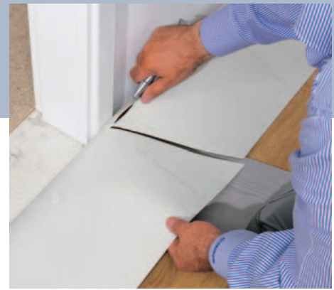
4 Müssen Türen oder Nischen berücksichtigt werden, wird Material in entsprechender Länge dazugegeben und das Übermaß abgeschnitten.
