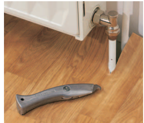
11 Bei Heizungsrohren wird der PVC-Boden zunächst gerade eingeschnitten und dann anschließend kreisrund herausgearbeitet.
