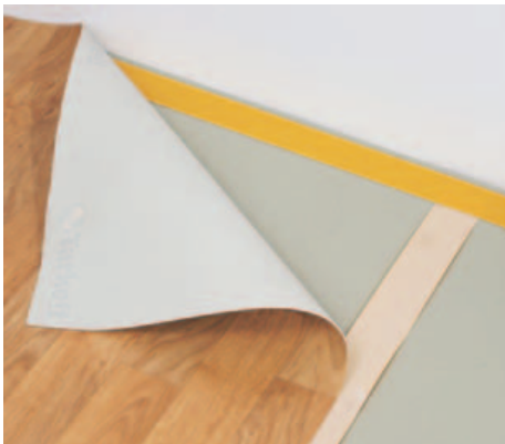
9 Anschließend die Naht von unten mit einseitigem Klebeband bekleben. Bei Doppelklebeband Schutzfolie der Unterseite dranlassen.
