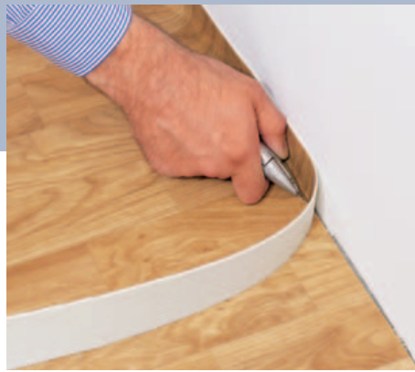
3 Mit der Hakenklinge werden die Raumkanten (bei demontierter Fußleiste) mit einer 1 mm breiten Dehnungsfuge nachgeschnitten.
