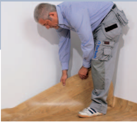
2 Die abgerollte Bahnenware aus einer rechtwinkligen Ecke beginnend auslegen. Tipp: Mit dem Fuß lässt sich das PVC gut positionieren!
