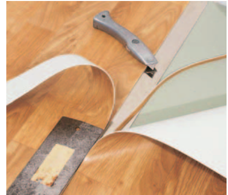
8 Beim Verlegen von mehr als einer Bahn führt man einen deckungsgleichen Schnitt an den Kanten durch beide Bahnen aus (Lauftext).
