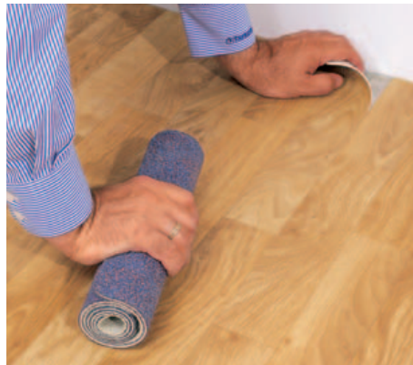
10 Das Gegenstück , also die zweite Bahn, ebenfalls auf das Klebeband legen und alles mit der selbstgefertigten Andruckrolle festreiben.
