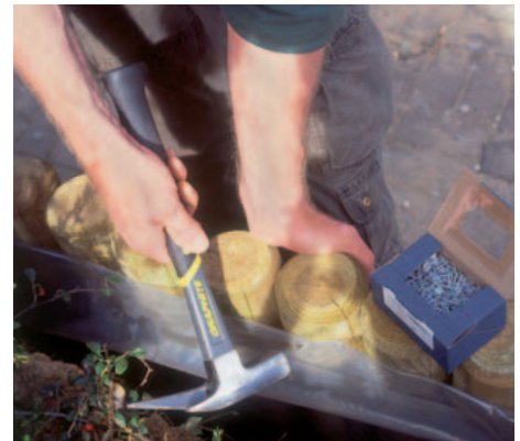
10 Eine Kunststoffolie zwischen Erdreich und Palisade genagelt, verhindert, dass Sand durch die Palisadenzwischenräume rieselt.
