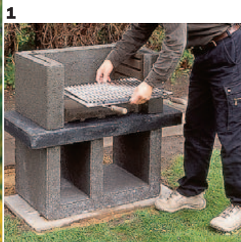
„Heißer Typ“ als Bausatz Der Grillkamin aus Betonfertigteilen muss präzise nach Montageanleitung zusammengesetzt und verklebt werden, damit der Grillrost auch perfekt sitzt.
