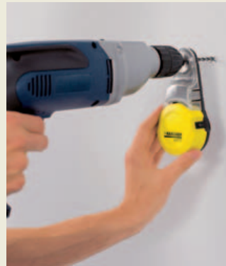
Den Bohrer an der Markierung an der Wand ansetzen. Erst danach kann der Bohrstaubfänger an die Wand angebracht werden.
