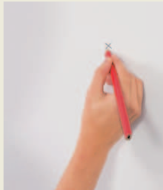
Das Markieren der Bohrstelle mit einem Bleistift ist für eine präzise Befestigung von Regalen und Hängeschränken sinnvoll.
