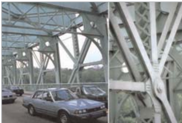
3 DER AUSSCHNITT ZÄHLT: Während links die Brücke kaum zur Geltung kommt, zeigt sich rechts das interessante Design.
