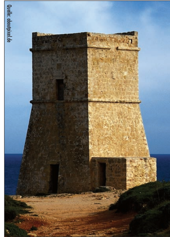
Mit Forefront TMG erneuert Microsoft seinen Sicherheitsvorposten für Unternehmensnetze
