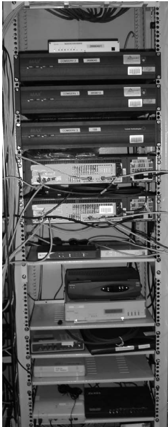
Abbildung 14.19 Ein Access-Rack. Oben sind drei Dial-in-Server, die einen Zugriff von je 120 Linien ISDN oder analog im Vollausbau bieten können. Weiter zwei Firewalls und etliche kleinere Router, die Mietleitungen terminieren.
