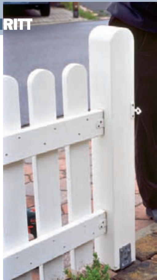
Die Beschläge vorerst nur mit einer Schraube fixieren, prüfen, ob Pforte und Zaun gleiche Höhe haben, dann restliche Schrauben eindrehen.
