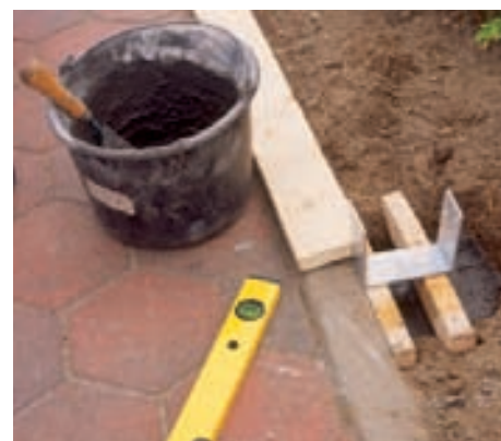
5 Den metallenen Pfostenschuh mit kleinen Hölzchen in Position bringen, fixieren und dann das Loch mit der Betonmischung verfüllen.
