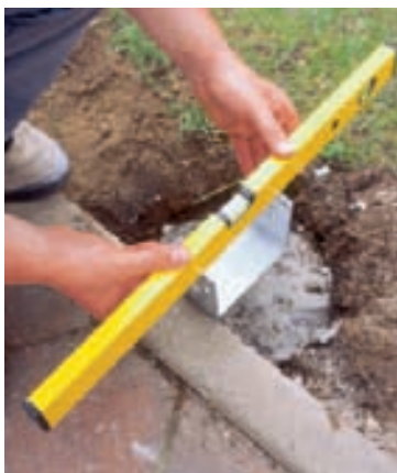
Die richtige Mischung: Perfekt für schwere Fundamente sind der Betonestrich plus Schnellbinder von Sakret. „Setz-Fix“ wird trocken ins Fundamentloch eingestreut und nur noch mit Wasser übergossen.
