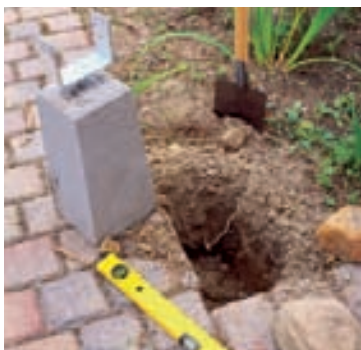
Fertige Betonsockel , in die Pfostenschuhe einbetoniert sind, werden eingegraben und seitlich mit Sand festgestampft.
