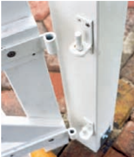
Die Beschläge vorerst nur mit einer Schraube fixieren, prüfen, ob Pforte und Zaun gleiche Höhe haben, dann restliche Schrauben eindrehen.
