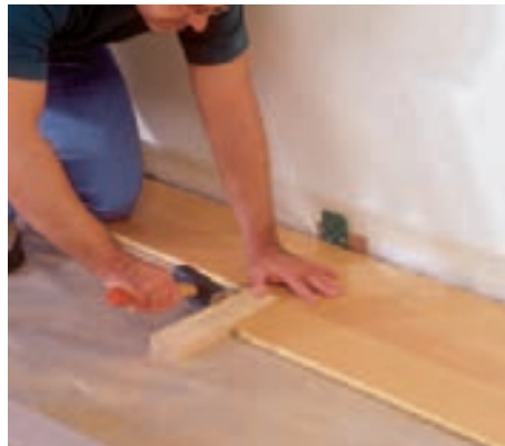
12 Bei noch offenen Fugen werden auch die Stirnseiten waagerecht mit Hammer und Zulageholz vorsichtig zusammengetrieben.
