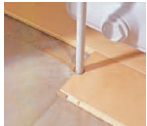
16 Günstig ist es , an Heizungsrohren die Längsstöße der Dielen zu setzen. Achten Sie aber wegen des Fugenbildes auf einen Mindestversatz.
