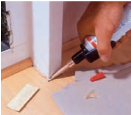
28 Die Fugen zu nicht nagel- oder schraubbaren Bauteilen (Stahlzarge) füllen Sie mit dauerelastischer Acrylmasse in Holzfarbe aus.
