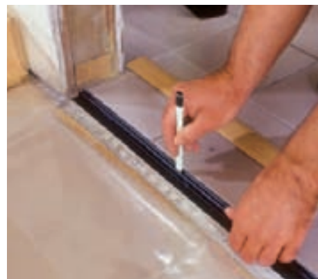
21 Setzen Sie die Grundschiene unter das später wieder einzuhängende Türblatt, markieren und bohren Sie die Dübellöcher.
