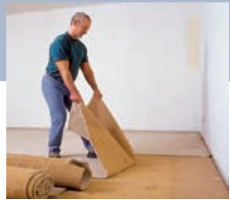
4 Die Streifen lösen Sie an der Wand mit einem Spachtel. Können Sie sie mit beiden Händen greifen, ziehen Sie sie einfach ab.
