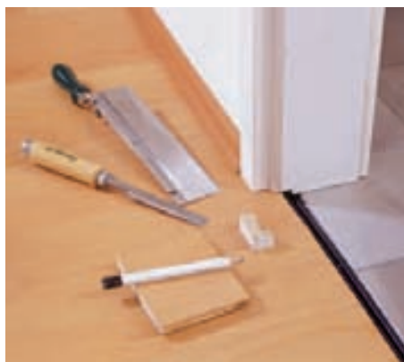
24 Können Sie Ihre Zarge nicht herausnehmen, kürzen Sie sie mit der Feinsäge um Dielenhöhe. Das Parkett schieben Sie dann unter die Zarge.
