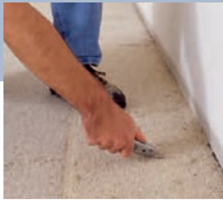
3 Den vollflächig geklebten Teppichboden schneiden Sie mit dem Cutter in 1-m-Streifen. Die lassen sich leichter rausreißen.
