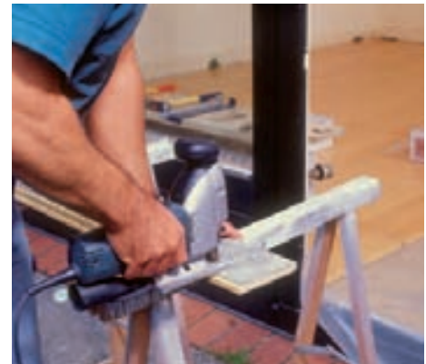
13 Zuschnitte für das jeweils letzte Dielenstück einer Reihe schneiden Sie mit einer Stichsäge. Sägen Sie immer auf der Dielenunterseite.
