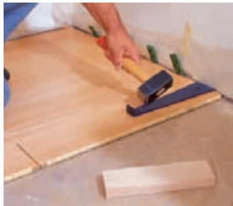
15 Die Stirnfuge der Diel schließen Sie dann per Zugeisen und Fäustel. Der Wandabstand sollte 15 mm nicht überschreiten.
