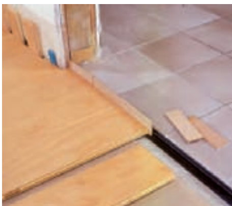
23 Verlegen Sie die Dielen wie gewohnt weiter. Sichern Sie auch hier eine Dehnungsfuge von 10 mm zur Übergangsschiene mit Holzstreifen.
