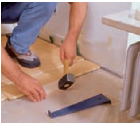
14 Die jeweils letzte Diel e einer Reihe setzen Sie stramm bündig an der Wand an und treiben zunächst die Längsseite zusammen.
