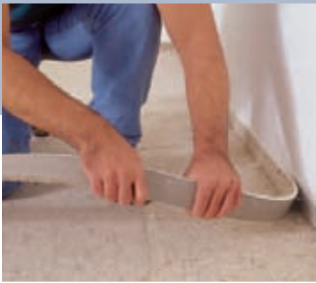
2 Die Teppich-Fußleisten sind meist nur genagelt oder geklebt. Sie können Sie leicht von Hand abziehen. Nägel gleich mit aus der Wand ziehen.
