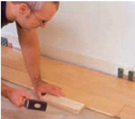
11 Mit Fäustel und Zulageholz treiben Sie die Dielen auf der Längsseite vorsichtig ineinander, bis die Fuge auf ganzer Länge geschlossen ist.
