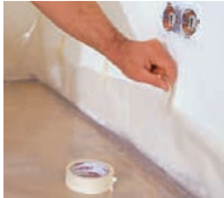
8 Vor dem Verlegen rollen Sie eine PE-Folie aus. Lassen Sie die Bahnen 10 cm überlappen und 20 cm an den Wänden hochstehen.
