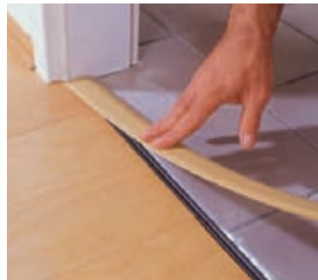
30 Zum Schluss setzen Sie die Deckschiene (passend nach ausgleichendem Niveau-Unterschied) an den Übergängen ein.
