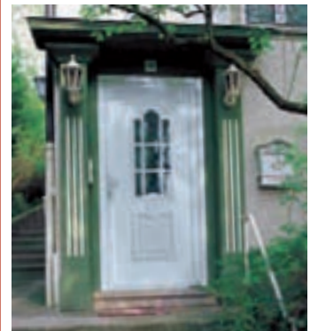
Denkmalpflege funktioniert mit neuen Türen in altem Stil. (Weru)
