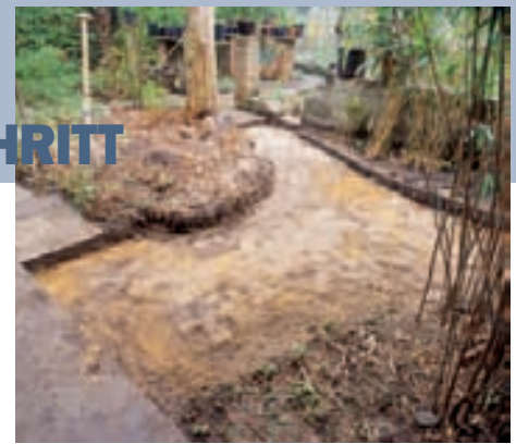
1 Die Flächen für den Weg werden vorbereitet: Eventuell alte Platten aufnehmen, die Form des Wegs festlegen und etwa 30 cm tief auskoffern.
