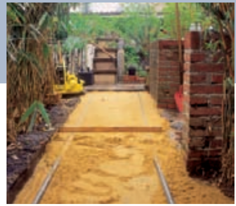
4 Erneut wird Sand eingefüllt, etwa 5 cm, und mit dem Richtscheit glatt abgezogen. Bei Bedarf zieht man die Rohre weiter und richtet sie aus.
