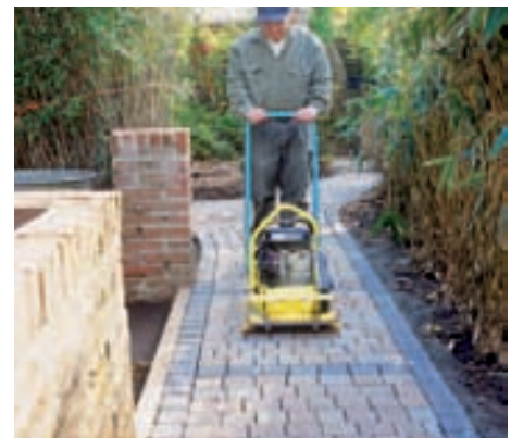
13 Ist der Splitt völlig eingefegt, werden die Pflastersteine mit dem Rüttler und einer schützenden Kunststoffmatte in das Sandbett getrieben.
