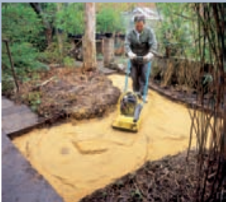
2 Der Verlegesand wird etwa 20 cm hoch eingefüllt, gleichmäßig verteilt und dann mit dem Rüttler sorgfältig verdichtet.
