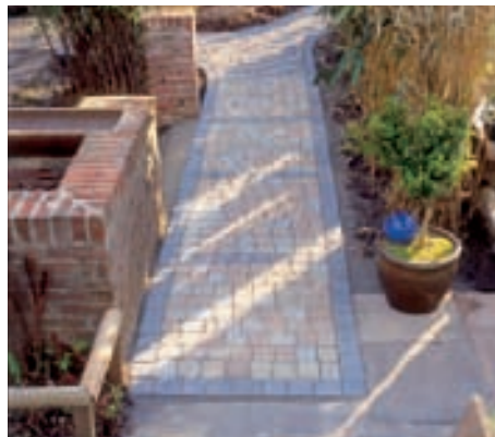
15 Der fertig gepflasterte Weg. Zwei Tage Arbeit zu zweit haben ein neues Schmuckstück im Garten entstehen lassen.
