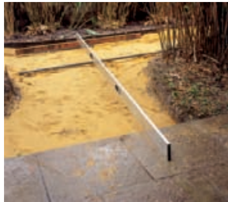
5 Wo das neue Pflaster auf vorhandene Wege trifft, gleicht man das Niveau mit der Wasserwaage an. Die Holzlatte hat die Höhe der Steine.
