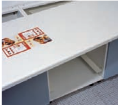
5 Die neue Arbeitsplatte auflegen und ausrichten. Nicht festschrauben, da erst noch das Kochfeld eingepasst werden muss.
