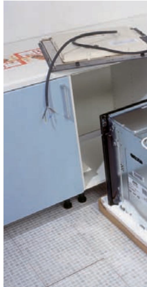
1 Der alte Zustand: Der einfache Elektroherd wurde zwischen zwei Unterschränke geschoben. Links und rechts grenzt je eine Arbeitsplatte an.
