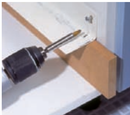
12 Ermitteln Sie die exakte Höhe und schneiden Sie sich eine entsprechende Hilfsleiste zu, um die Schienen genau auszurichten.
