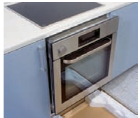
13 Den Backofen wieder einschieben. Jetzt kann der Elektroanschluss von Kochfeld und Backofen vorgenommen werden.
