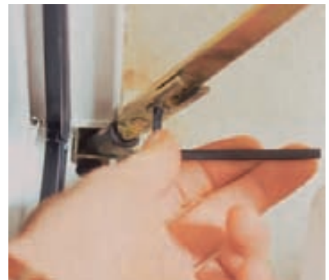
10 Das bewegliche Schließstück an der Unterseite der Kippschere ist ebenfalls verstellbar. Hier lässt sich das Fenster diagonal verstellen.
