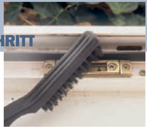
1 Schmutz in den Schließblechen führt zu Spannungen im Getriebe und an den Schließzapfen. Reinigen Sie sie daher mit einer Bürste.
