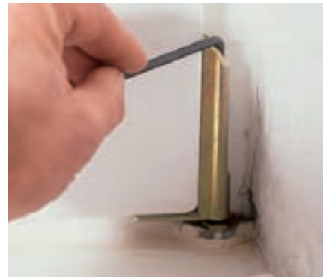
7 Ins Eckband ist ein Gewindestift eingelassen, über den der Flügel senkrecht um bis zu 3 mm angehoben werden kann.
