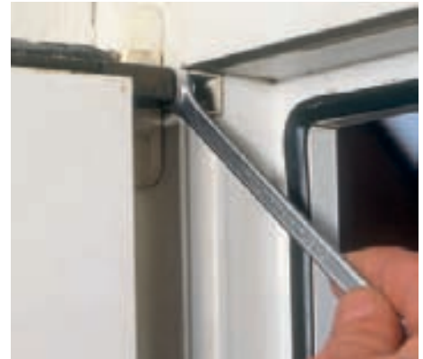
5 Über eine Stellschraube am hinteren Ende der Kippschere kann der Flügel um bis zu 5 mm diagonal gesenkt oder gehoben werden.
