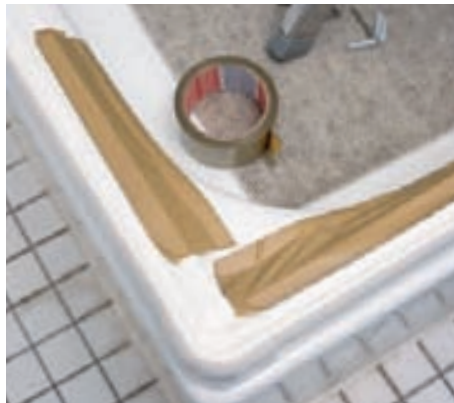
16 Die ausgerichteten unteren Querträger werden mit Paketklebeband auf der Duschwanne fixiert, bevor die Silikonfuge gezogen wird.
