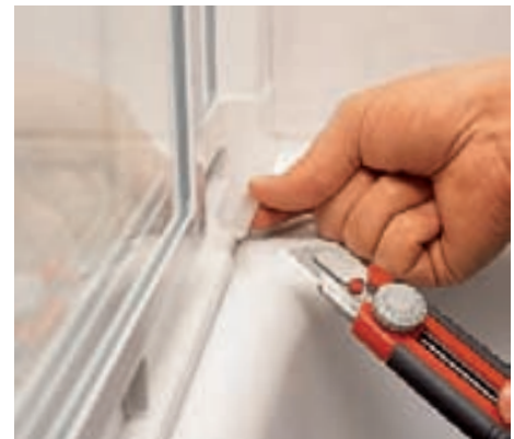
15 Durch Anpassen der Querträger an die Länge der Duschwanne entstehen Schlitzlöcher, die mit einem Dichtprofil von innen geschlossen werden.
