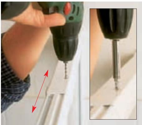
13 Die in Länge und Winkel ausgerichteten Querträgerprofile werden von oben vorgebohrt und anschließend mit Schrauben festgesetzt.
