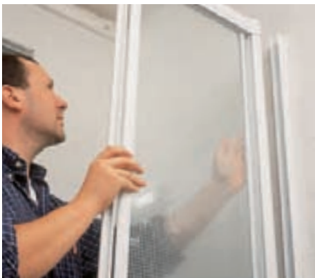
9 Nun die zwei Glaselemente (festes Teil mit Schiebetür) nacheinander in die Schienen schieben, jedoch noch nicht festschrauben.
