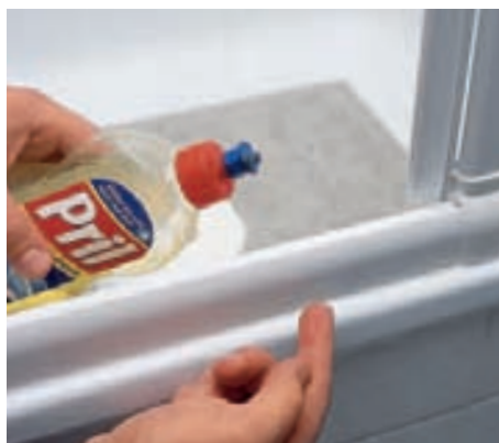
20 Zuletzt mit Hilfe von Spülmittel oder einer Spülmittel-Wasser-Mischung und dem Finger das Silikon glatt streichen und trocknen lassen.
