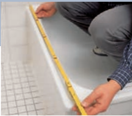
1 Der erste Schritt vor dem Kauf oder dem Bestellen: das Ausmessen der Duschwanne und das Festlegen der Duschwandhöhe.
