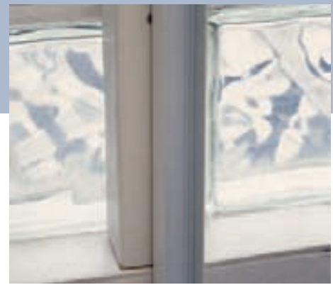
3 Auch große Versprünge – hier an einem Glasbausteinfenster – lassen sich mit gehobelten Vierkanthölzern gut überbrücken.
