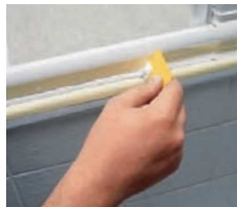
19 Mit einem Fugenwerkzeug (in elastischem Material, aus dem Baumarkt) an der Fuge entlanggleiten und den Überstand abnehmen.
