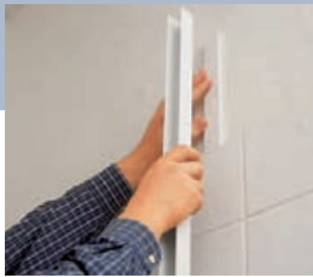
2 Eventuelle Absätze an der Wand, wie hier durch den niedrigen Fliesenschicht, müssen mit hölzernen Distanzleisten ausgeglichen werden.
