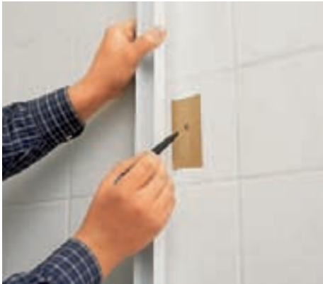
6 Ein Stück Paketkleband auf den Fliesen verhindert, dass der Steinbohrer beim Ansetzen abrutscht und die Oberflächen zerkratzt.
