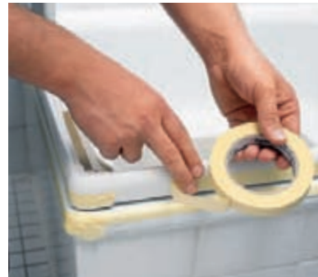
17 Mit glattem Malerband klebt man nun die Fuge über- und unterhalb ab, damit das Silikon später einen geraden Abschluss findet.
