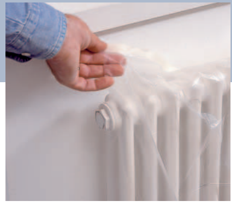
4 Die Abdeckfolie mit dem selbstklebenden Rand eignet sich auch zum Abdecken von Heizkörpern. Dazu den Heizkörper ausstellen.
