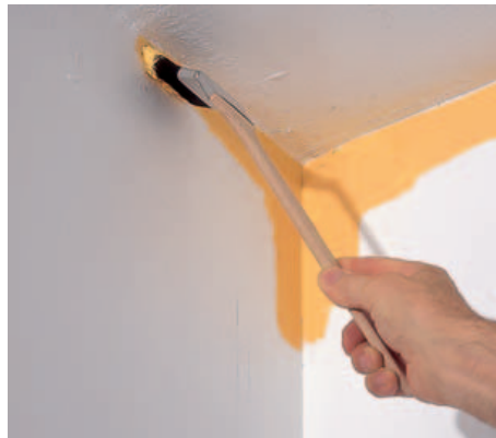
10 Mit einem Heizkörperpinsel wird die Kante (Beschnittkante) zur Decke beschnitten. Dazu den Pinsel nicht zu tief in die Farbe tauchen.
