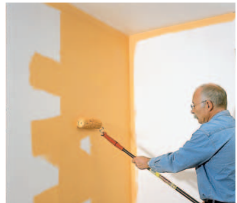
16 Nach der Kreuz-und-quer-Verteilung wird die Farbe mit gerade überlappenden Bahnen senkrecht von oben nach unten nachgezogen.
