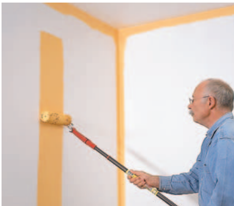
14 Die sattgetränkte Rolle wird erst einmal von unten nach oben geführt. So kleckert ihnen die Farbe nicht gleich auf den Boden.
