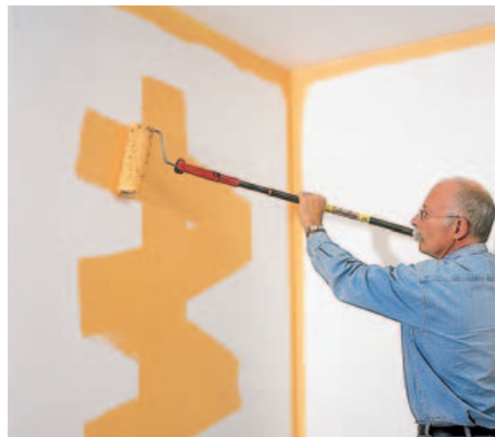
15 Der dickaufgetragene Farbstrich muss nun quer verteilt werden, dann sofort den nächsten Strich setzen und querverteilen (nass in Nass).
