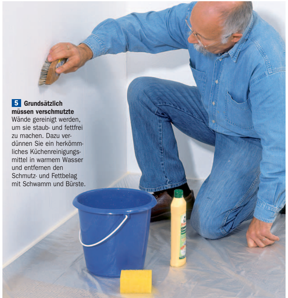
1 Abdeckfolie mit selbstklebenden Rand kann nach dem Bestigen auseinander gefaltet werden und deckt so fast den ganzen Boden ab.
