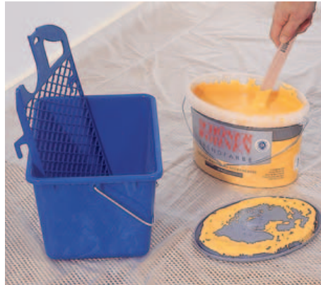
7 Bevor die neue Farbe verarbeitet wird, muss sie gut aufgerührt werden, denn die schwereren Pigmente setzen sich gern auf dem Boden ab.
