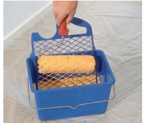
8 Um einen gleichmäßigen Farbauftrag zu erreichen, muss die Rolle nach dem Eintauchen an dem Abstrichgitter ausgerollt werden.
