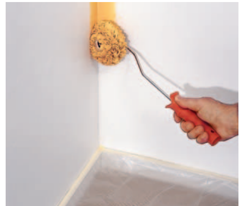
11 Eine große Hilfe ist diese Rolle: Der speziell „Eckenroller“ hat einen kegelförmigen Walze und eignet sich so für 90°-Innenwinkel.
