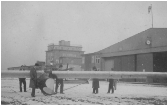
Auf diesem Bild ist der Fall-Benzintank am Spannturm bereits montiert worden.
