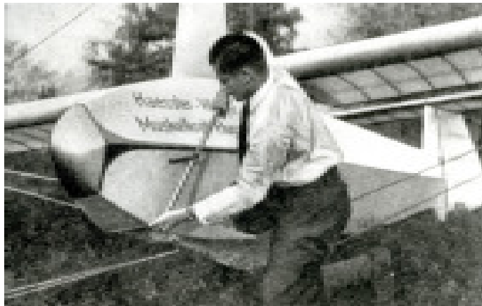
Kraftakt für Helmut Haeßler: Er spannt an der ersten Version der H.V. 1 das ausgelegte Gummiseil, wobei gleichzeitig das Gummiseil im Rumpffinneren vorgespannt wurde.
