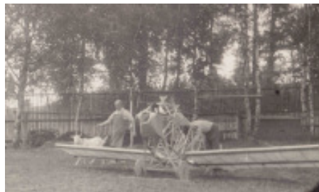
Das Leichtflugzeug von Herbert Gropp als Rohbau auf dem Grundstück des Elternhauses in Siebenhöfen bei Geyer (1929)
