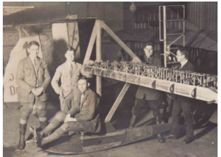
Unten: Gleitflugzeug „Hangwind“ der Interessengemeinschaft für Segelflug Dessau im Bau. Die Zögling-Konstruktion stammt von Alexander Lippisch und Fritz Stamer.
