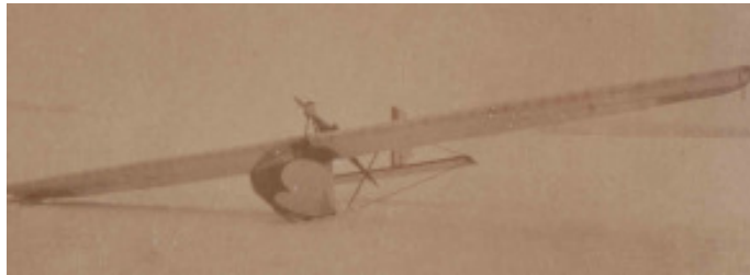
„Zaunkönig“ mit JAP-Motor nach der Umrüstung auf eine untergesetzte 2,35-m-Holzluftschraube auf dem Chemnitzer Flughafen.
