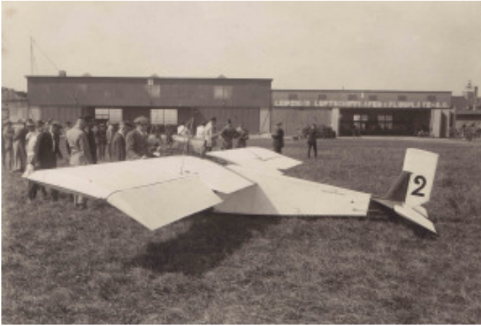
Aus Herbert Gropps Fotoalbum (links): Arthur Martens MM 3 „Hans Huckebein I“ mit DKW-Motor (12 PS) in Leipzig. Fertiggestellt wurde die MM 3, eine Konstruktion von Martens (Frankfurt a.M.), im Juli 1927 in der Werkstatt der Griesheimer Firma Gebrüder Müller für die Teilnahme am Sachsenflug 1927.
