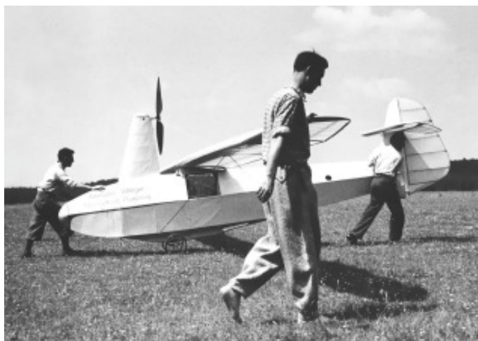
Von links: Franz Villinger, Heinrich Hofmann und Helmut Haeßler auf dem Wege zum Startplatz in Meiningen. Sie schieben die verbesserte H.V. 1 - erkennbar am gedämpften Höhenleitwerk, das zuvor nur aus einer (feststehenden) Flosse bestand.
