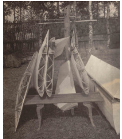
Die Baugruppen des Leichtflugzeuges (1929). Das Flugzeug entstand in bespannter Holzbauweise.
